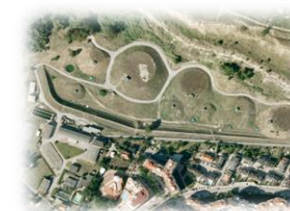
Reservatório na zona II
