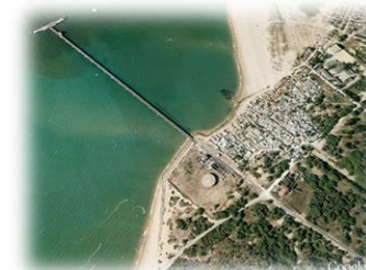
Cais Terminal Petrolífero
